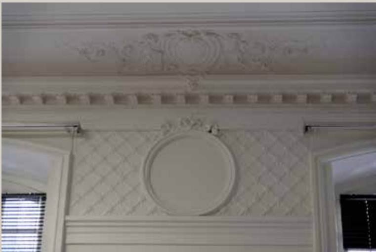
Détail du décor du salon du rez-de-chaussée du n° 17.
