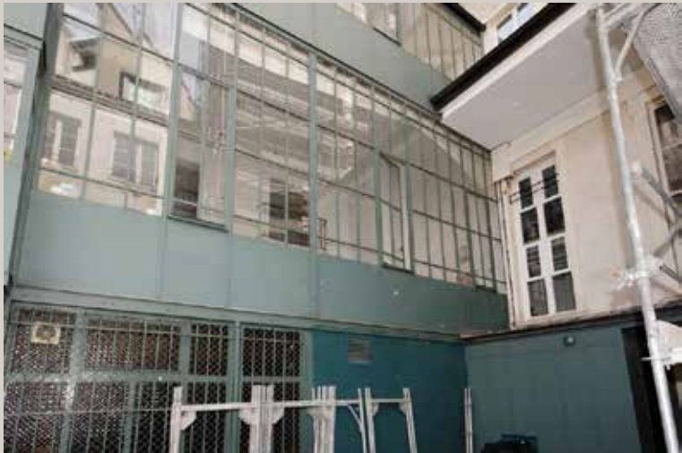
Vue actuelle de la façade vitrée au revers de l’immeuble rue Cambon.
