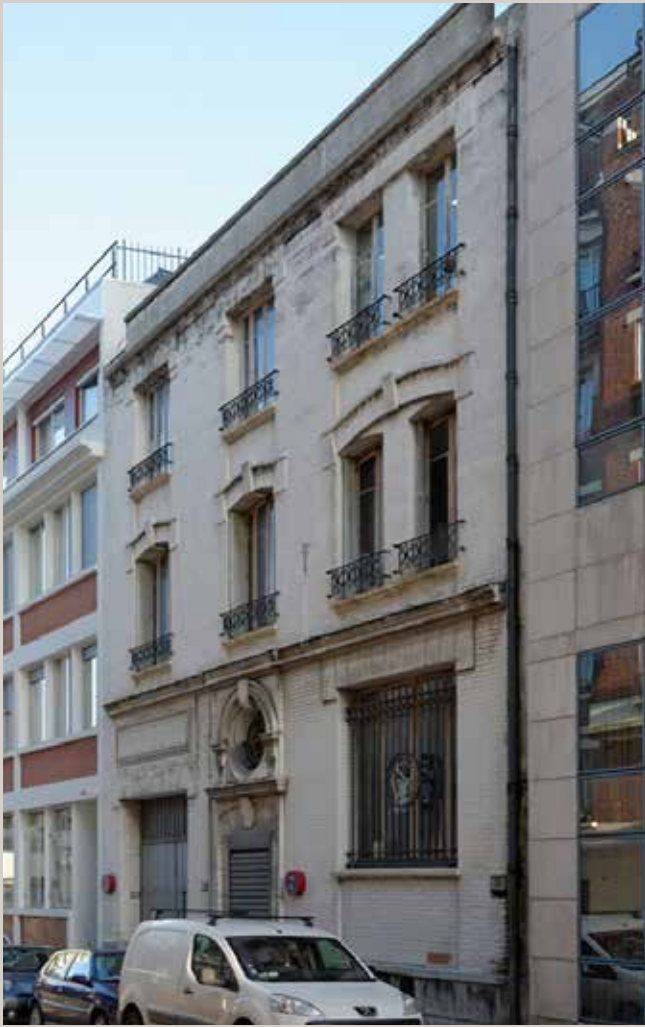
Vue actuelle de la façade du 48, rue Alphonse Penaud.
